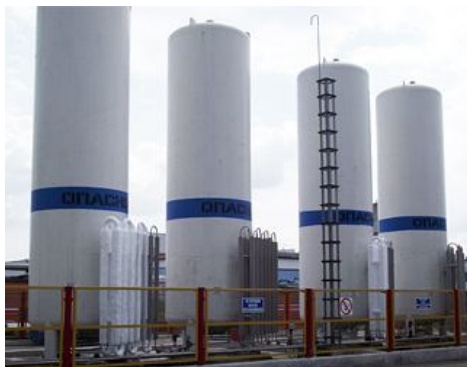
а) емкости с жидким кислородом на ОАО «Гомельстройматериалы»
