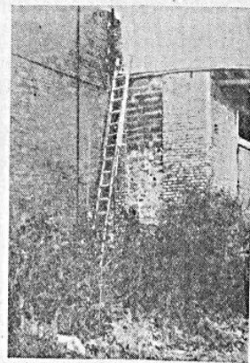
Фото № 4. Место, откуда преступники по лестнице поднимались на крышу склада.
