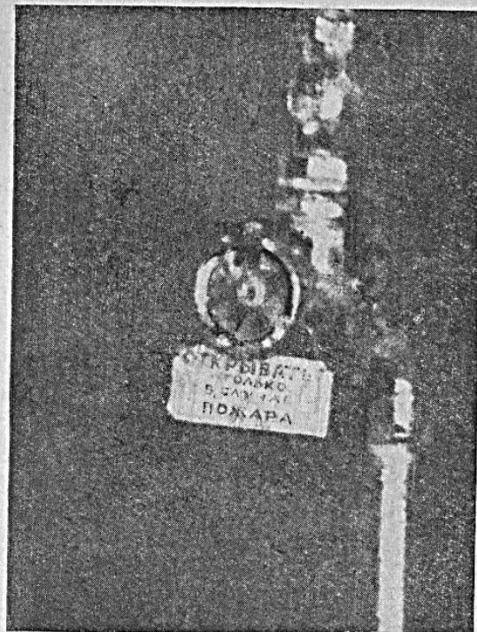
Рис. 3. Табличка из солонита на пусковом вентиле с надписью «открывать только в случае пожара».
