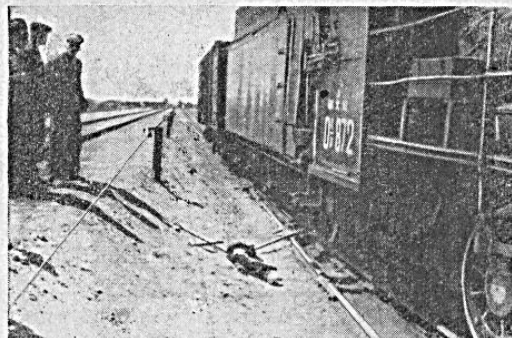
Рис. 4. Положение паровоза и чучела при втором заезде после остановки при торможении на расстоянии 56,5 м
