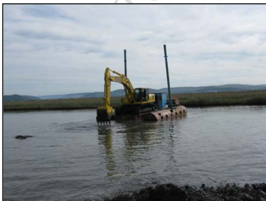
Рисунок 1 – Прокладка трубопровода через водную преграду обычным (траншейным) способом
