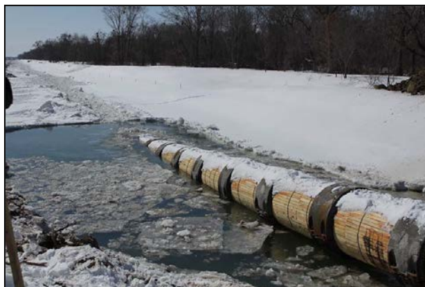
Рисунок 1 – Прокладка трубопровода через водную преграду обычным (траншейным) способом
