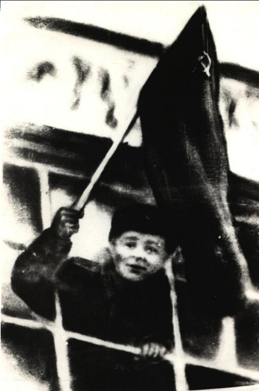
Ефрейтор 2-й роты 39-го стрелкового полка М.И. Васильев укрепляет флаг на здании городской электростанции (ныне ТЭЦ-1)
