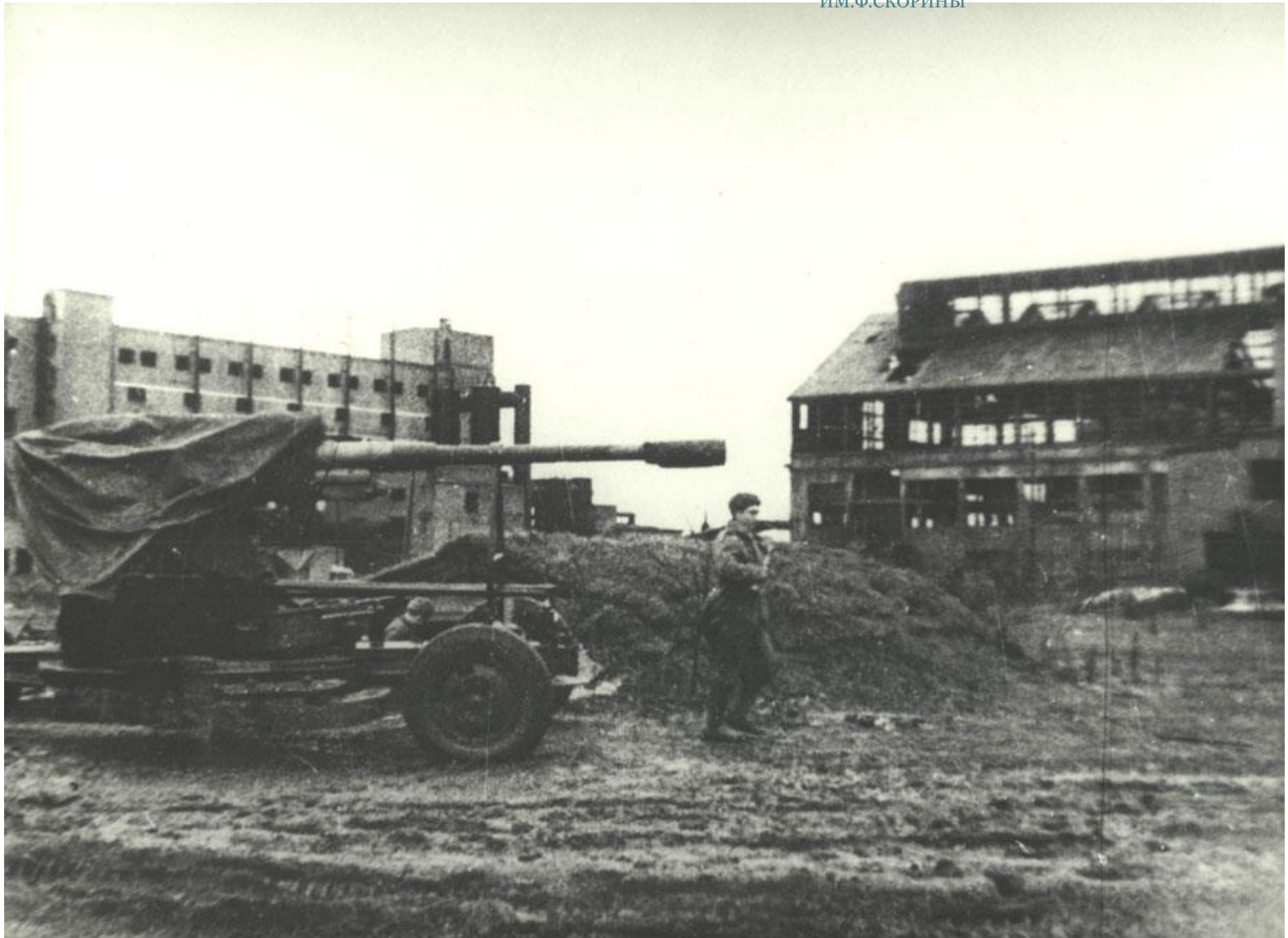
Разрушенное здание электростанции
