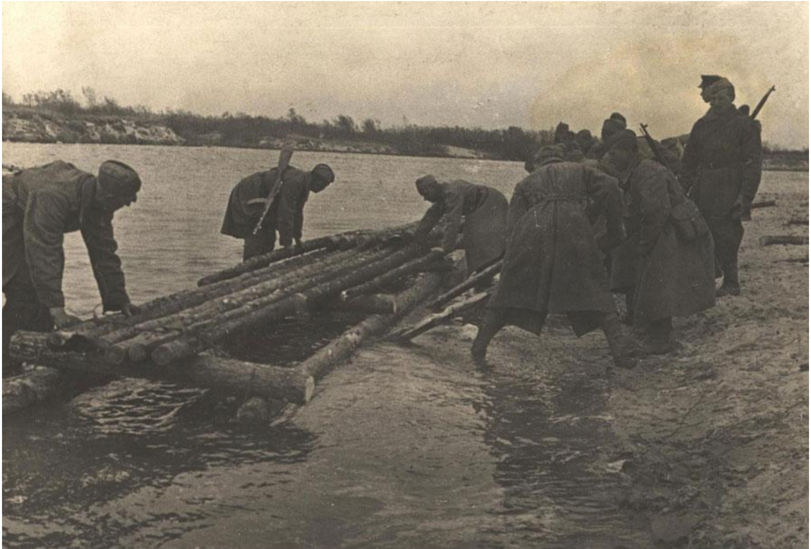
Бойцы сооружают мост через реку Сож
