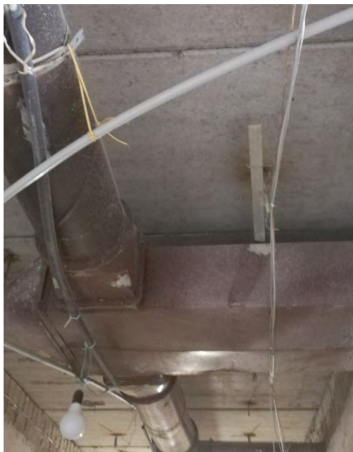
Рис. 1. Пример заполнения пленумных полостей и их внешний вид после монтажа потолка
