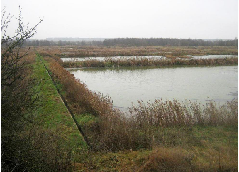
Рисунок 8. Иловые площадки станции очистки сточных вод г. Береза [17]
