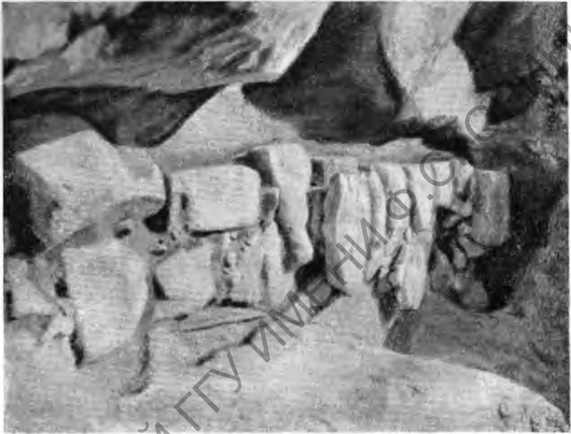
Рис. 1. Вид опорной каменной кладки глинобитной стены
