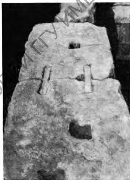
Рис. 4. Деталь кладки южной стены с металлическими скобами
