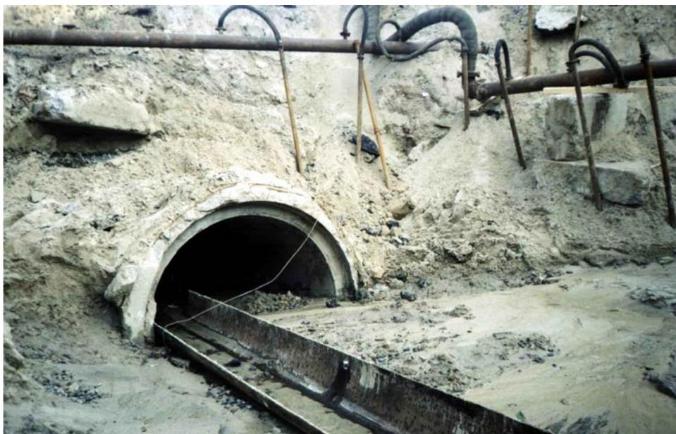
Рисунок 12 – Развитие суффозионного процесса по трассе коллектора дождевых вод, ул Хатаевича (сентябрь 2003 г.)
