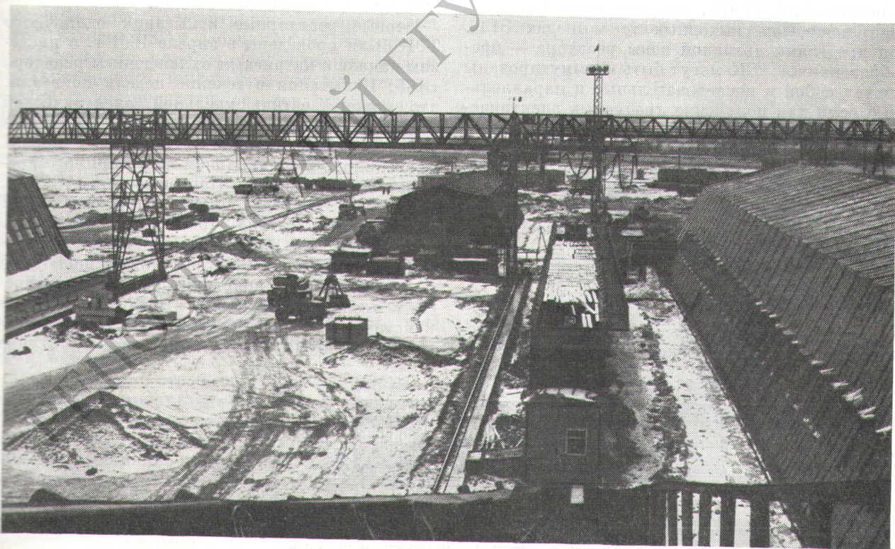
Смоленская АЭС. Вид на строительную площадку (конец 1973 г.).
