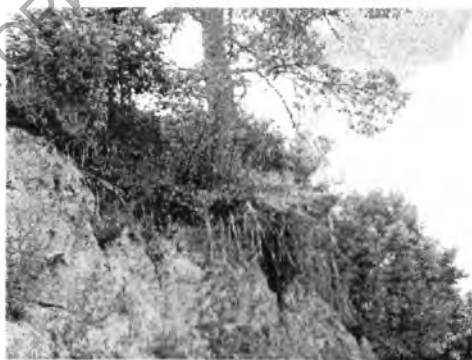
Рисунок 10 – Формирование оползневого склона (эрозионный берег Днестра, н.п. Переделка, июнь 2006 г.)
