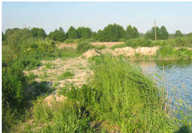
Рисунок А. 1. Территория станции по очистке сточных вод, г. Береза
