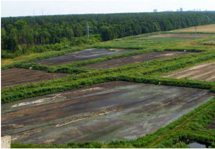
Рисунок А. 5. Территория станции по очистке сточных вод, г. Гомель (у полигона ТБО)
