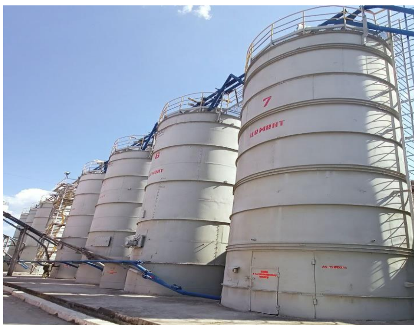
Рисунок 2 – Бункера для цемента с рукавными фильтрами
