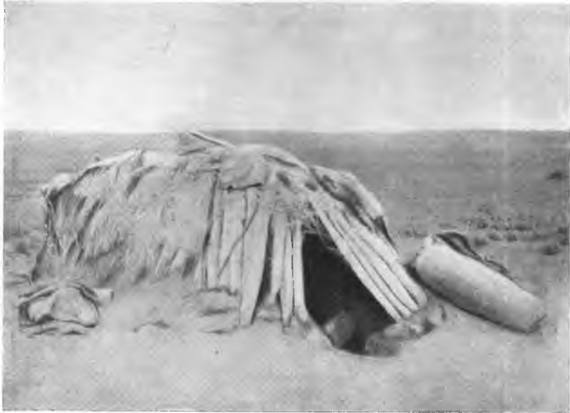
Рис. 8. Полуземлянка, верх которой представляет собой род шалаша из стволов доремы, покрытого гребенщиком и кусками войлока. Фото МАЭ, 3888—12
