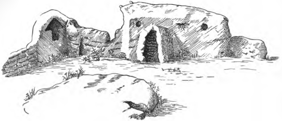
Рис. 13. Глинобитный дом «дувал-пол». Слева в утолщении стены — кормушка для лошади. На переднем плане — круглое земляное возвышение, на которое ставится на зиму чаппари внутри двора. Зарисовка автора
