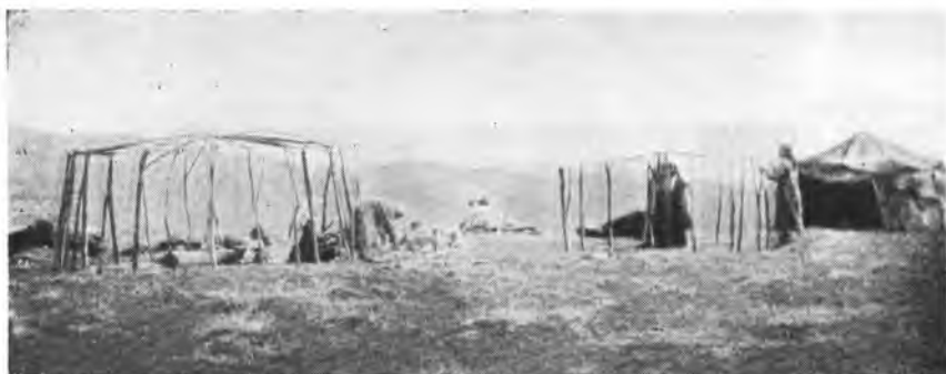
Рис. 3. Установка остова чаппари. Фото МАЭ, 3838—14
