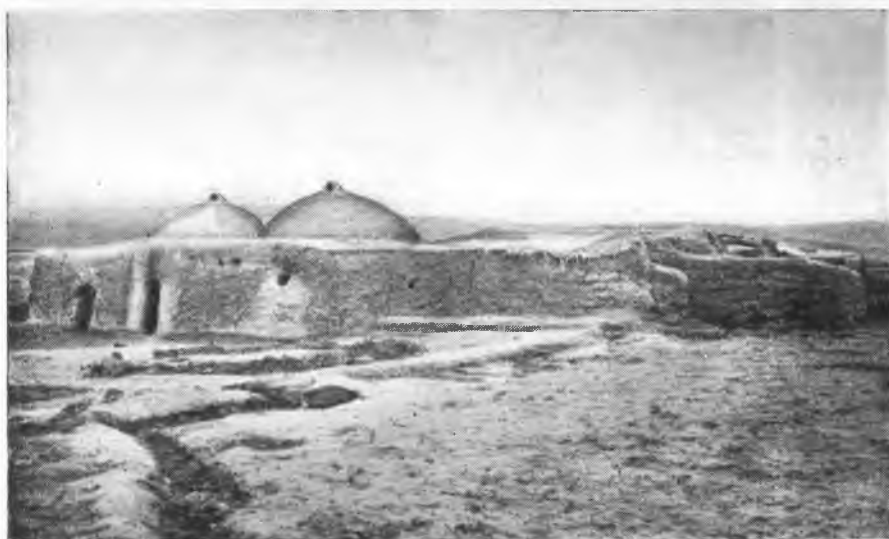
Рис. 14. Дом зажиточного джемшида из кирпича - сырца, с куполами. Сзади к дому пристроены хлева. Фото МАЭ, 3888—3
