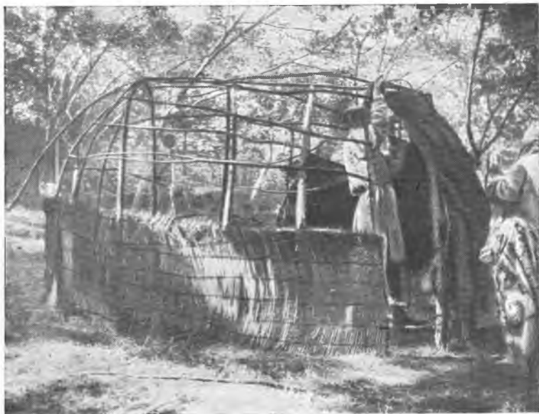
Рис. 10. Установка таджикской капы. Навешивание боковых кошм на остов капы, обведенный чиём. Сел. Урмитан Фальгар. Фото МАЭ, 3489-66
