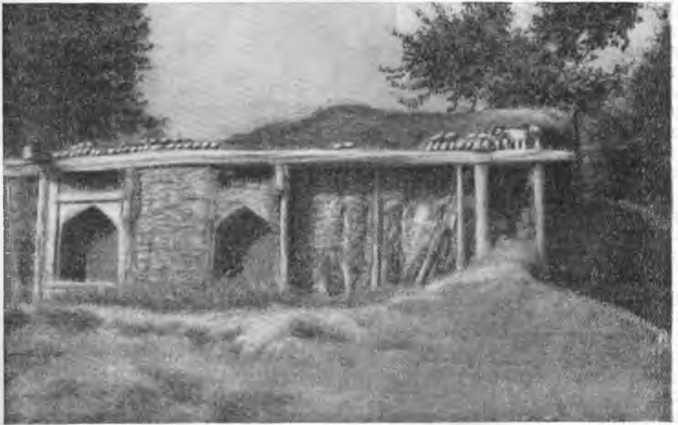
Рис. 3. Разрушенный дом в Шахрисябзе; видна внутренняя система каркаса. Фото автора
