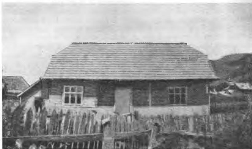
Рис. 76. Внешний вид хыжи в Воловом. Новостройка
